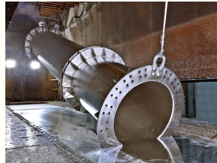
Nagyméretű acélszerkezet horganyzása a NAGÉV CINK Kft. ócsai üzemében
