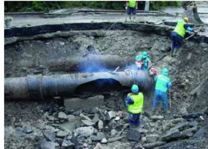
6. fotó: Öntöttvas vezeték csőtörés, 2003, II. Árpád fejedelem útja, DN800 (1935)
