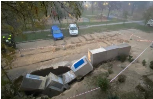
8. a), b) fotó: DN300 PVC (1980) cső törése, 2022-ből, a XXI. Kiss János altábornagy utcában
