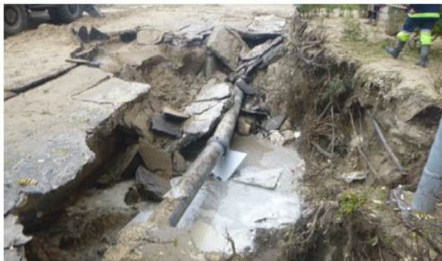
8. a), b) fotó: DN300 PVC (1980) cső törése, 2022-ből, a XXI. Kiss János altábornagy utcában
