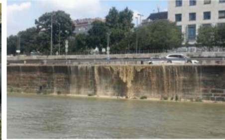
3. fotó: SENTAB vezeték meghibásodása, 2019, V. Széchenyi rkp., DN1200 (1974)
