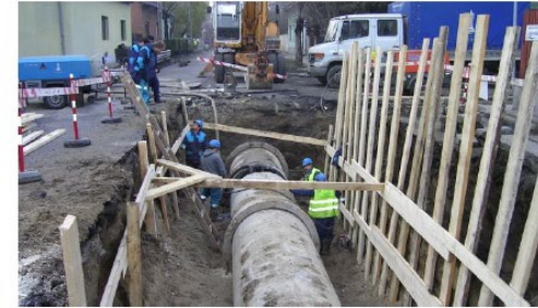
1. fotó: SENTAB vezeték meghibásodása, 2005, XXI. Kőlcsey utca, DN1200 (1981)
