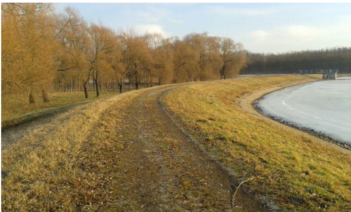
Zúzottkőborítás a zárótöltésen
