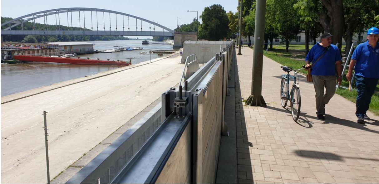
11. ábra Mobilfal szakasz kialakítása a Stefánián Forrás: Dr. Kozák Péter
