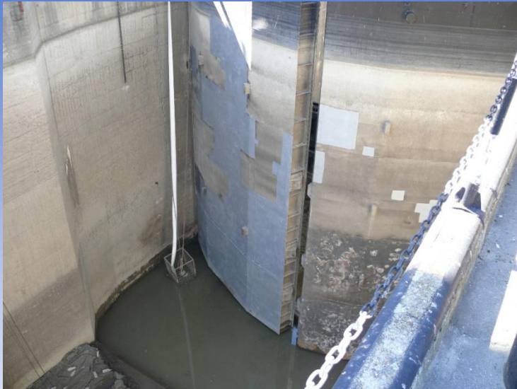
Támkapuk korrózióvédelme
