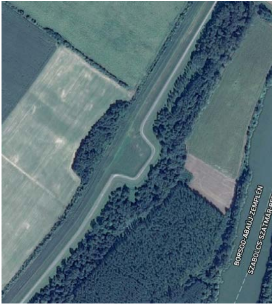
21. kép Nagycigándi gátszakadás a Tisza jobb parton, helyreállítása a vízoldalon
