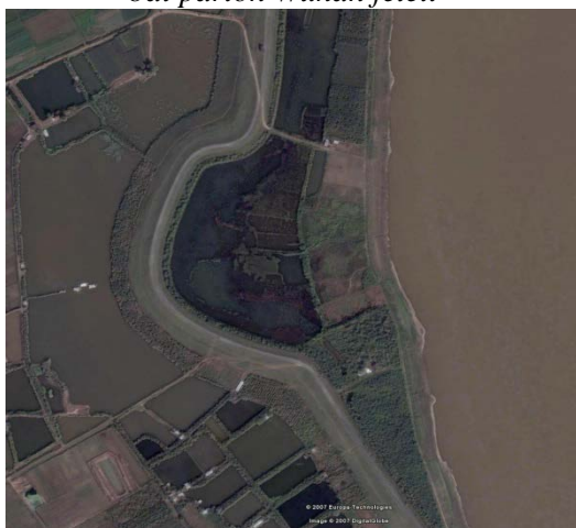
7. - 8. képek Kopolyák kikerülése az árvízvédelmi gát helyreállításával a Vörös folyó mellett (Vietnam). Egy vízoldali és egy mentett oldali helyreállítás.
