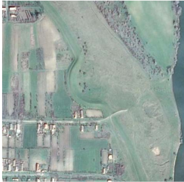
22. kép Egresi gátszakadás helyreállítása a Maros bal parton
