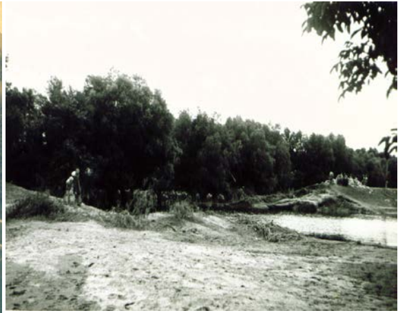
2. kép Az 1954. évi szigetközi árvíz gátszakadásának kopolyája
