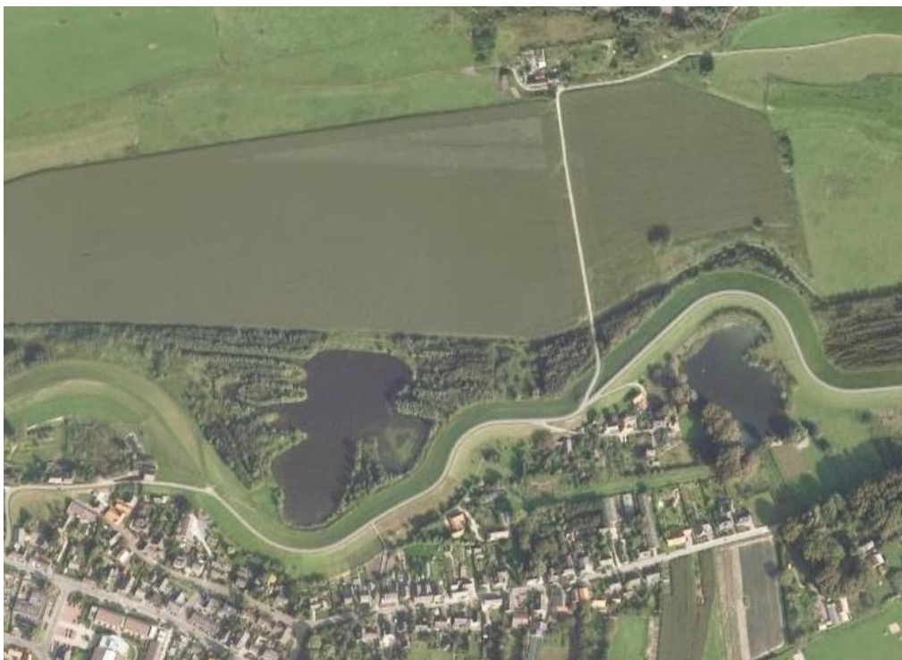
3. kép Sorozatos szakadások következtében kialakult gát nyomvonal
