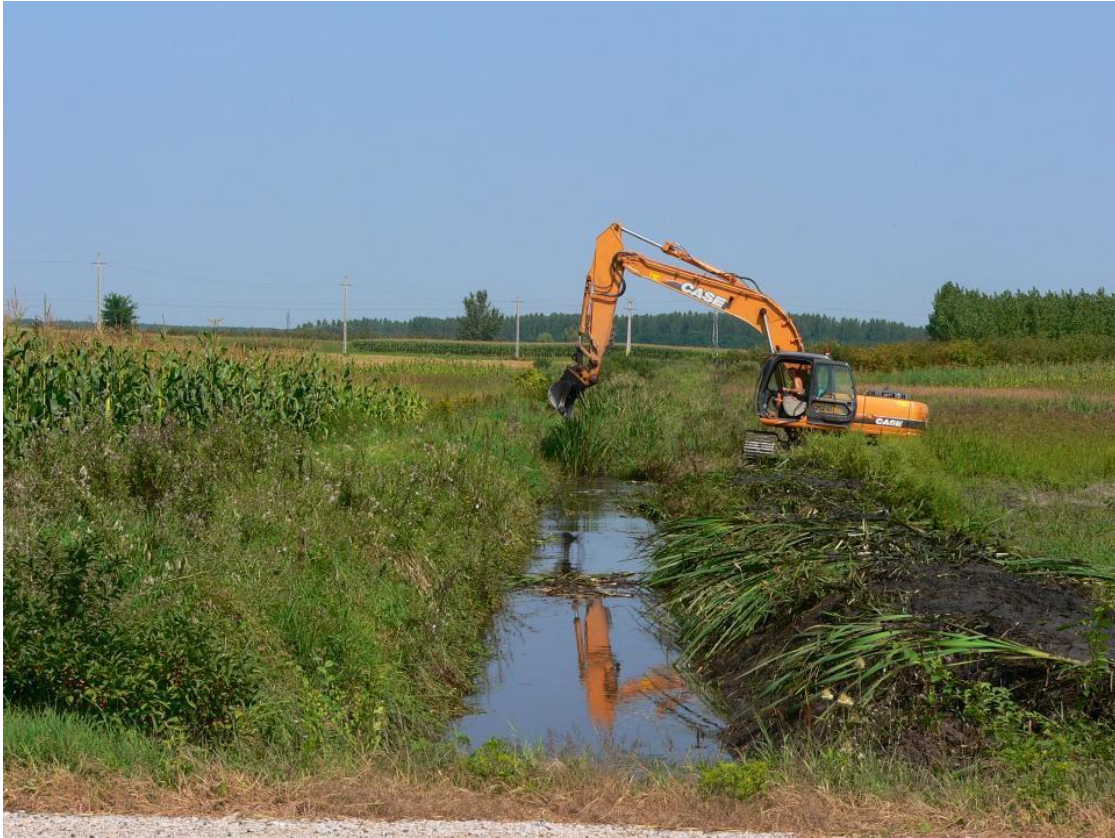
Csatorna kotrási munkálatok iszapoló kanállal
