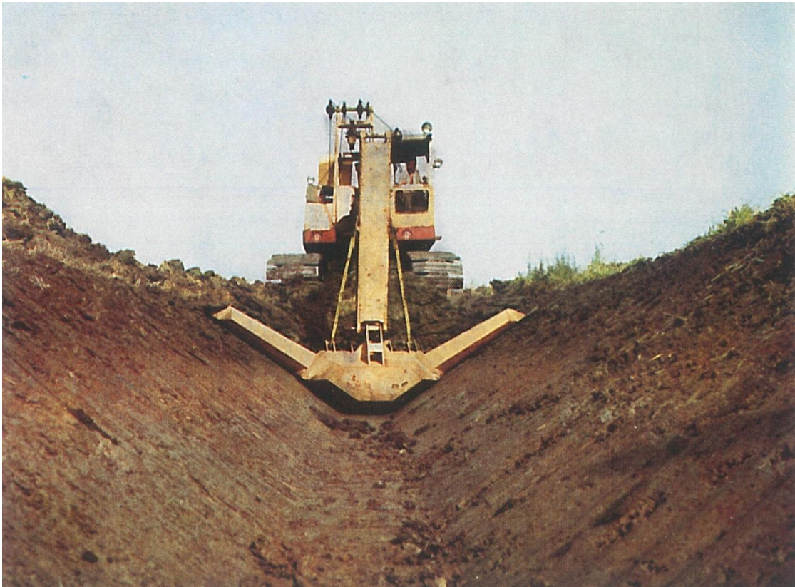
Csatornaépítés egy menetben
