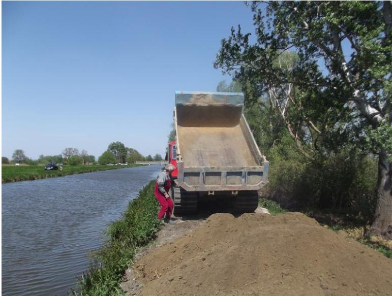
2.kép Depónia erősítési munkálatok (Kollárovics 2015)
