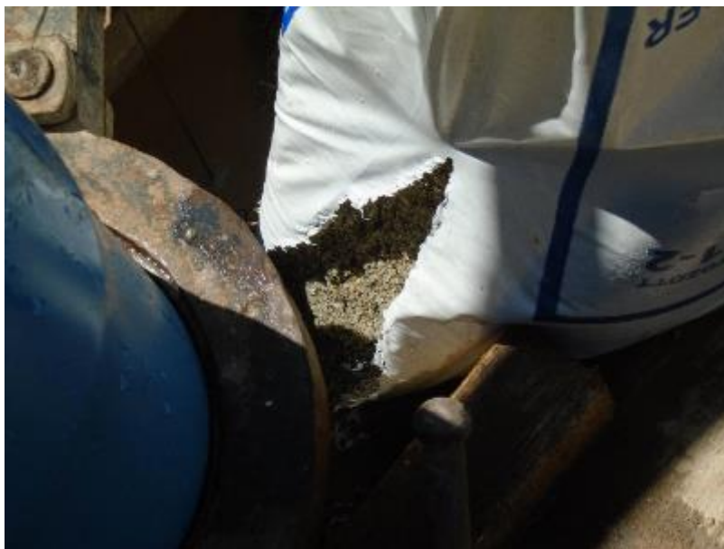
12. 1-2 mm-es kvarc szűrőkavics fúrólukba juttatása
