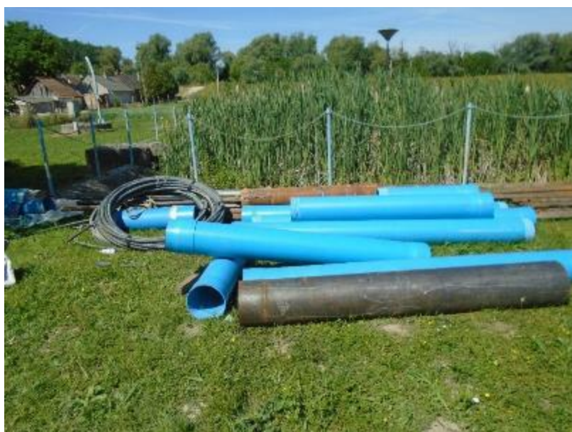
9. A furat anyagát képező NA 300-as PVC csövek és a 2m-es acél védőcső
