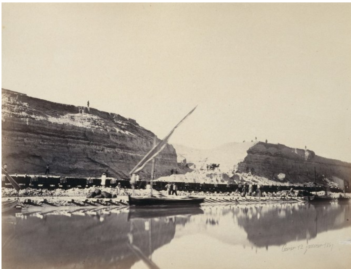
32. kép Az El-Guisr magaslat homokdombjainak ásásakor keletkezett egyik suvadás
