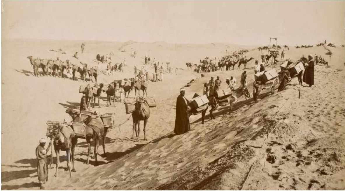
24. kép Földmunka a kezdeti időkben, a kiásott földet teve és öszvér karavánok hordták el fa ládákbán
