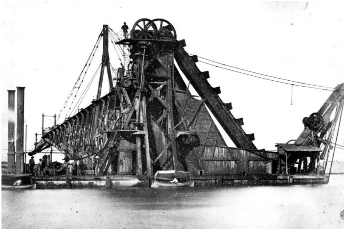
26. kép 1863-ban hagyták el fokozatosan a földmunka száraz technológiáját, vedersoros kotró a Szezi-csatorna építésénél
