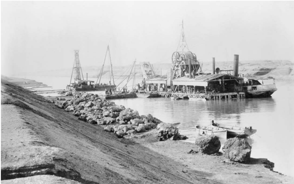
31. kép A csatorna ásásakor a mederből kiemelt diszpergáltan elhelyezkedő kövek a csatorna partra kihelyezve
