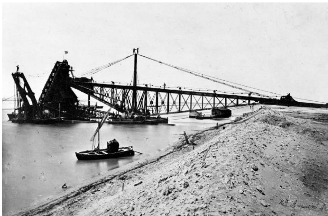
33. kép Kotró 40 méteres szállítószalaggal
