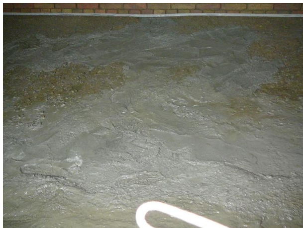
47., 48. képek: Alaplemezen található előkészített egyenletlenségek kitöltése
