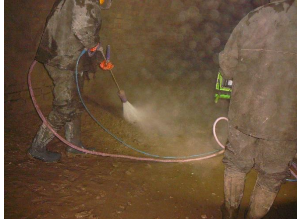
41., 42., 43., 44., 45., 46. képek: Alaplemez tisztítása, fészkek feltárása, visszavésése
