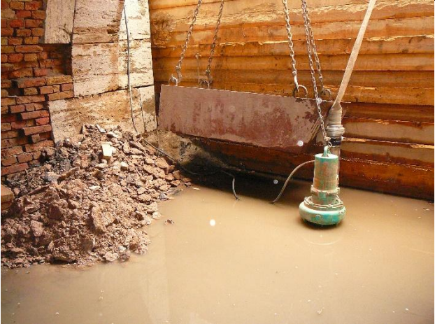
41., 42., 43., 44., 45., 46. képek: Alaplemez tisztítása, fészkek feltárása, visszavésése
