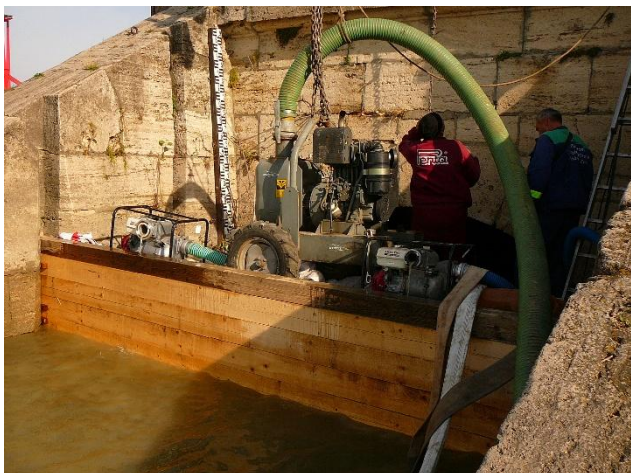
21., 22., 23., 24., 25., 26. képek: Gerendazár kiépítése, bent rekedt Dunavíz szivattyúzása, csatornaszelvény látképe a bent rekedt víz eltávolítását követően
