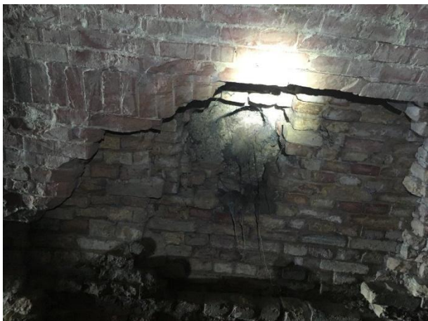
3., 4., 5., kép: Boltozat utólagos áttörése
