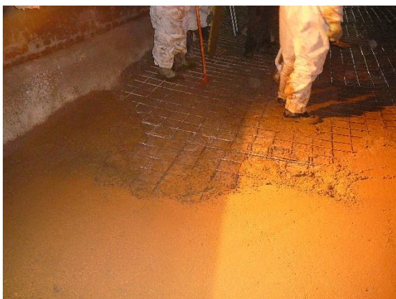
49., 50., 51., 52., 53., 54., 55., 56. képek: Kopóréteg készítése alaplemezre, oldalfali lábazatra
