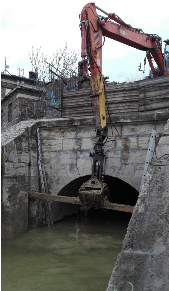
57., 58., 59., 60. képek: Gerendazár bontása, helyreállított kitorkolló műtárgy
