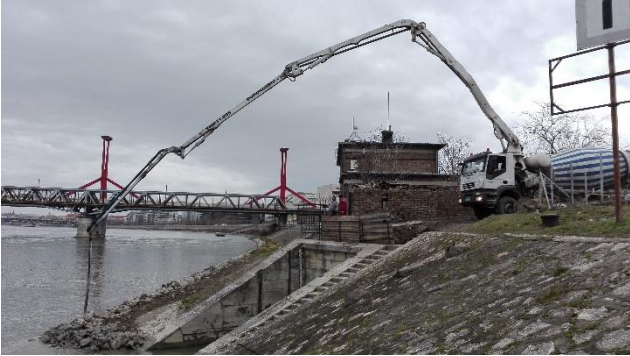
57., 58., 59., 60. képek: Kőszórás helyreállítása, injektálása
