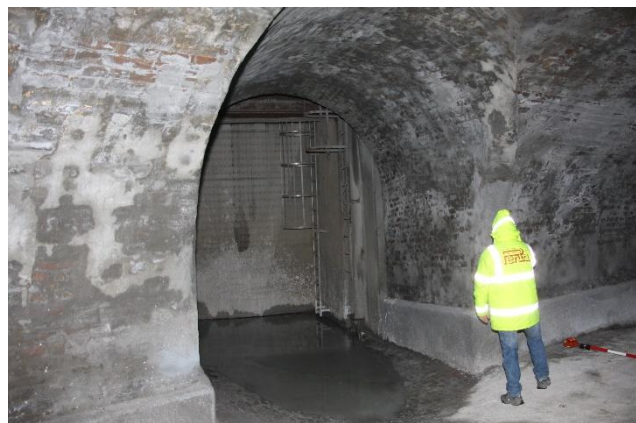
61., 62., 63., 64., 65., 66. képek: A helyreállított záporkiömlő szelvény
