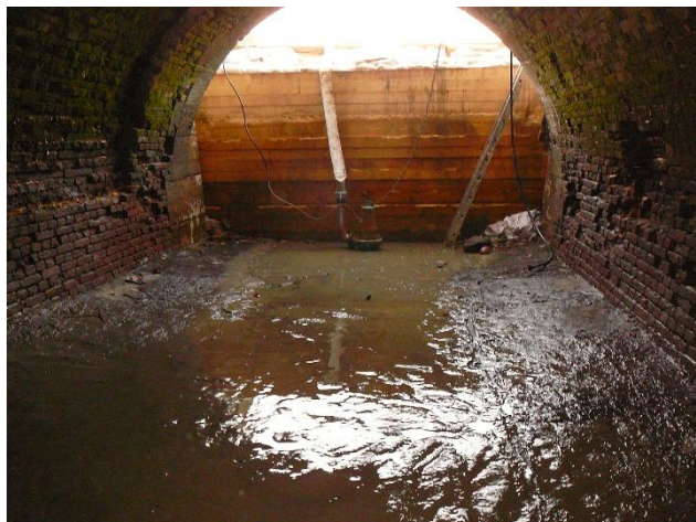
21., 22., 23., 24., 25., 26. képek: Gerendazár kiépítése, bent rekedt Dunavíz szivattyúzása, csatornaszelvény látképe a bent rekedt víz eltávolítását követően
