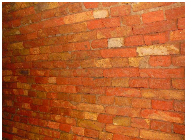
27., 28., 29., 30. képek: Téglafelület tisztítása magasnyomású vízsugárral, a megtisztított téglafelület
