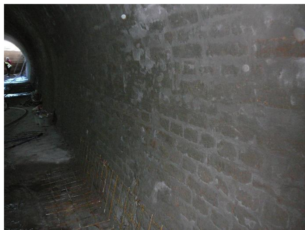
37., 38., 39., 40. képek: Fuga hiányos felületek javítása betonlövéssel
