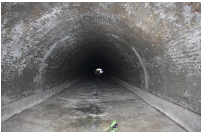
61., 62., 63., 64., 65., 66. képek: A helyreállított záporkiömlő szelvény
