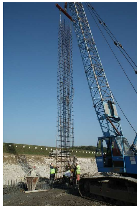
2. kép: Részarmatúra behelyezés 2013-ban Mályvádi Alsó megnyitási hely
