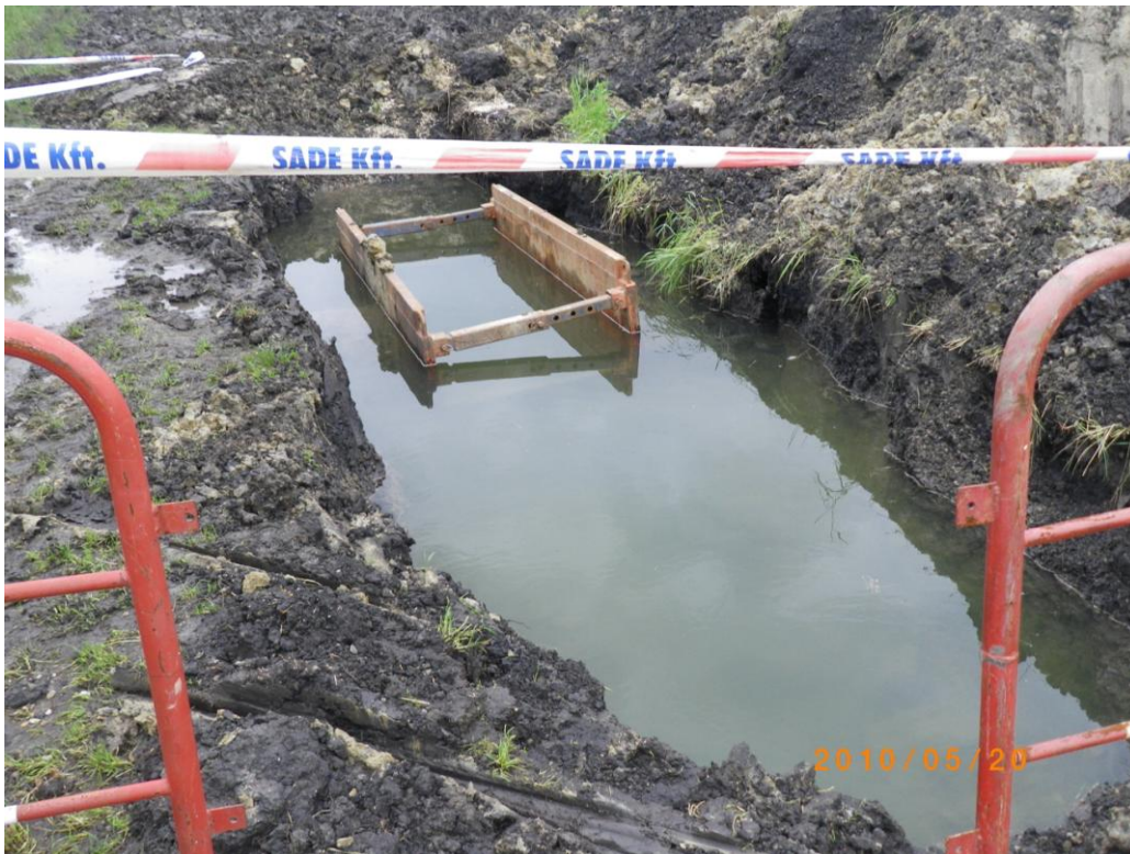
2. kép: Csatorna építés Békéscsabán 2010-ben
