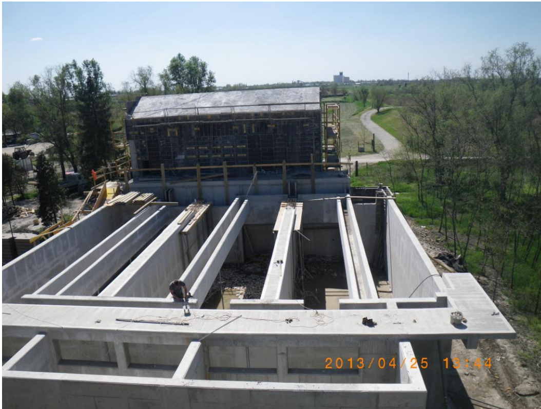
5. kép: Békéscsabai szennyvíztisztító telep épülő előmechanikája
