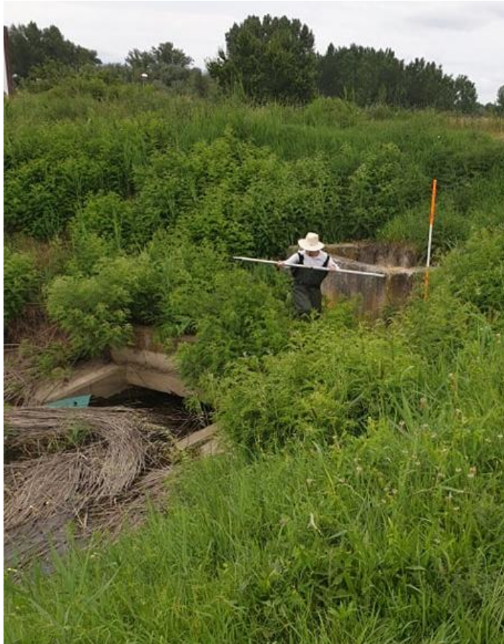
14. ábra A Körös-éri csatorna torkolati műtárgya a Tiszánál
