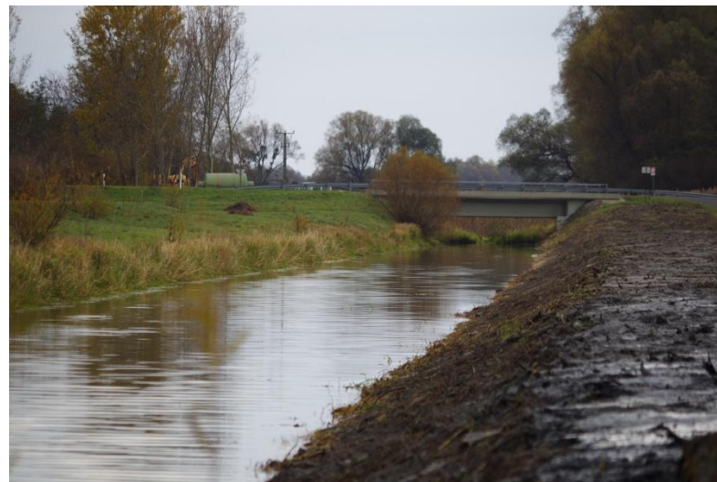
Marótvölgyi csatorna 3+733 fkm
