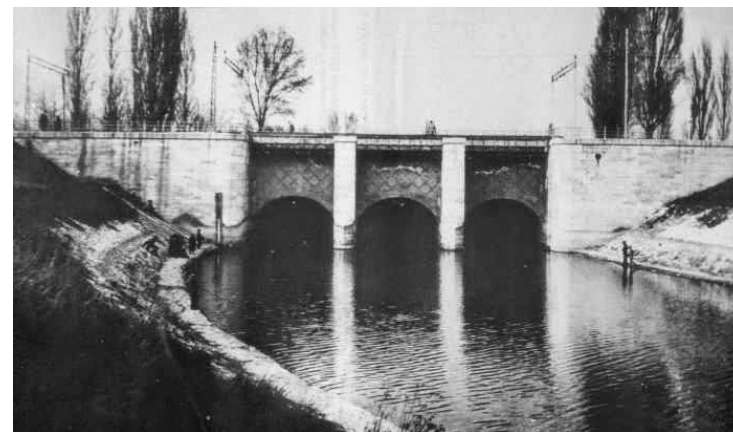
30 m 3 /s vízátbocsátó képességű tápszilip
