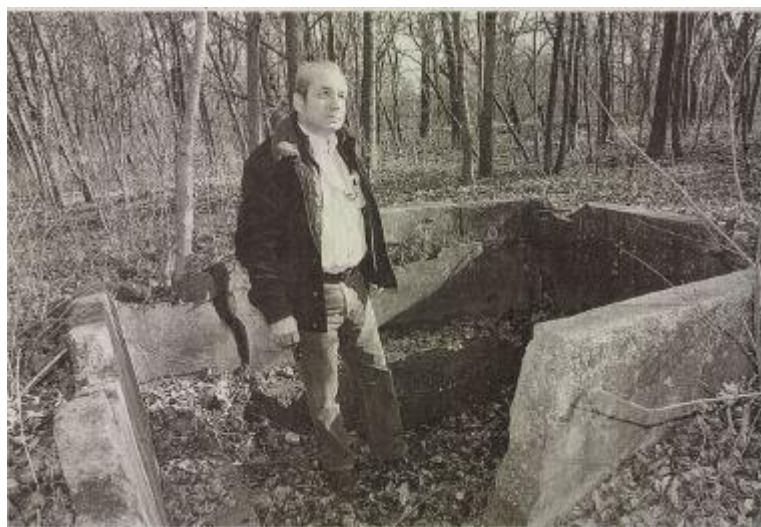
2. számú kép. Az egyetlen megmaradt betonmedence romjai
