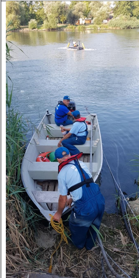
15. kép Robbanómotoros vízszugaras levegőtető egység telepítése
