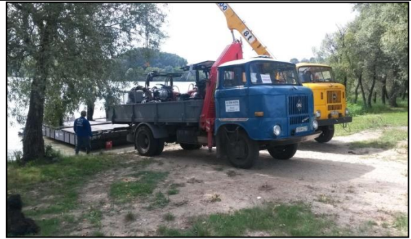
3. kép: A szivattyúk hídmezőre helyezése
