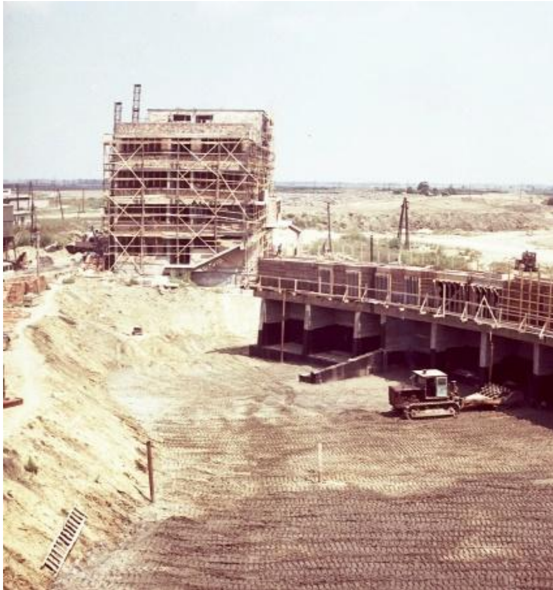
Igazgatási épület és a felvízi támfal építése
