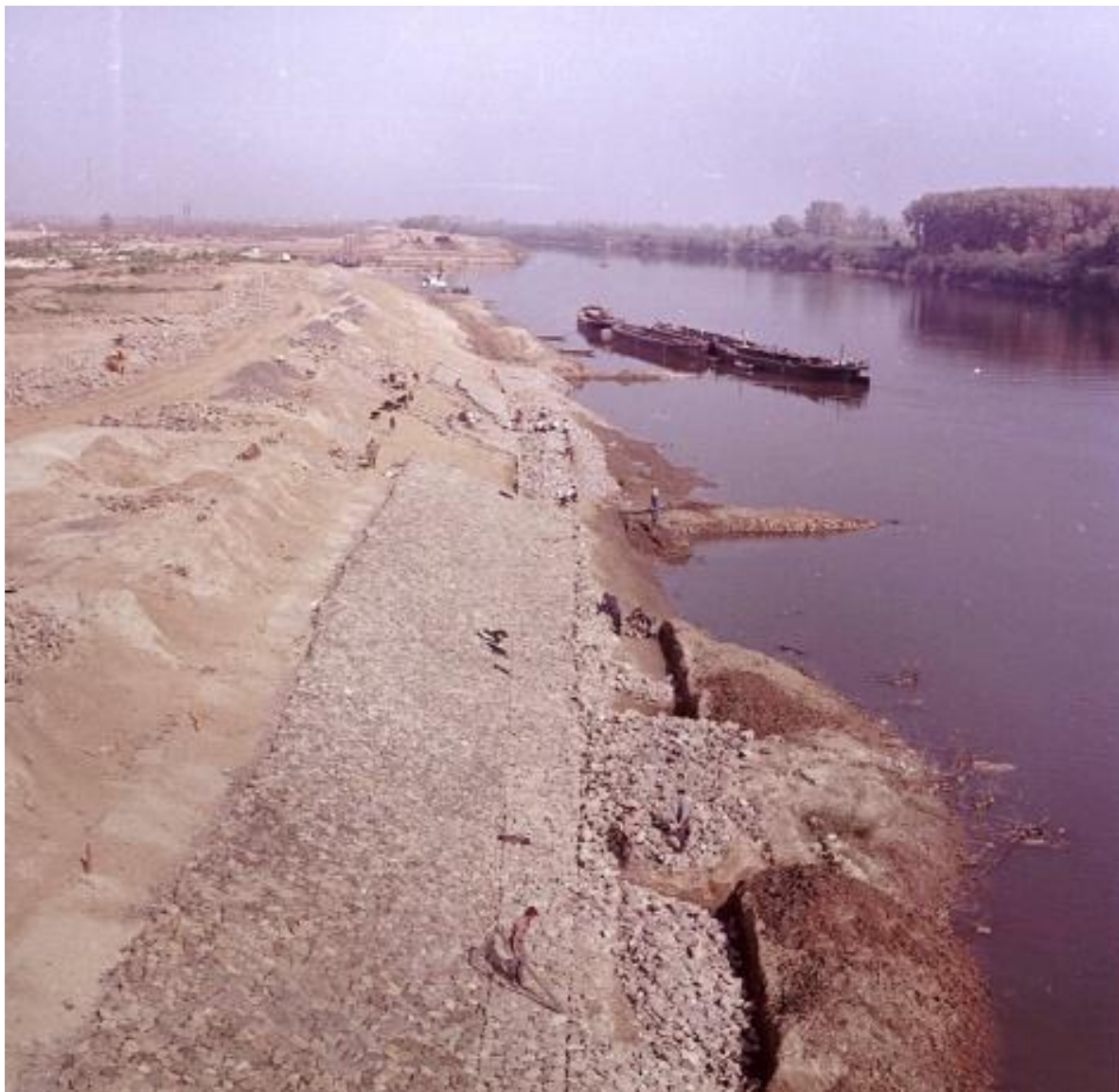
Partvédő mű építése kőből
