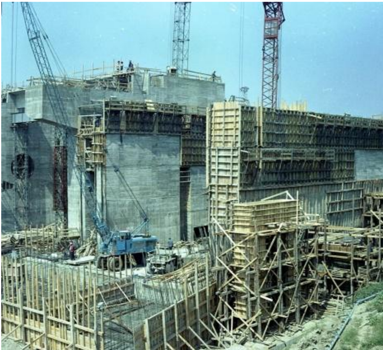
Hajózsilip építése nagytáblás (2 x 3,5 m) zsaluzási módszerrel
