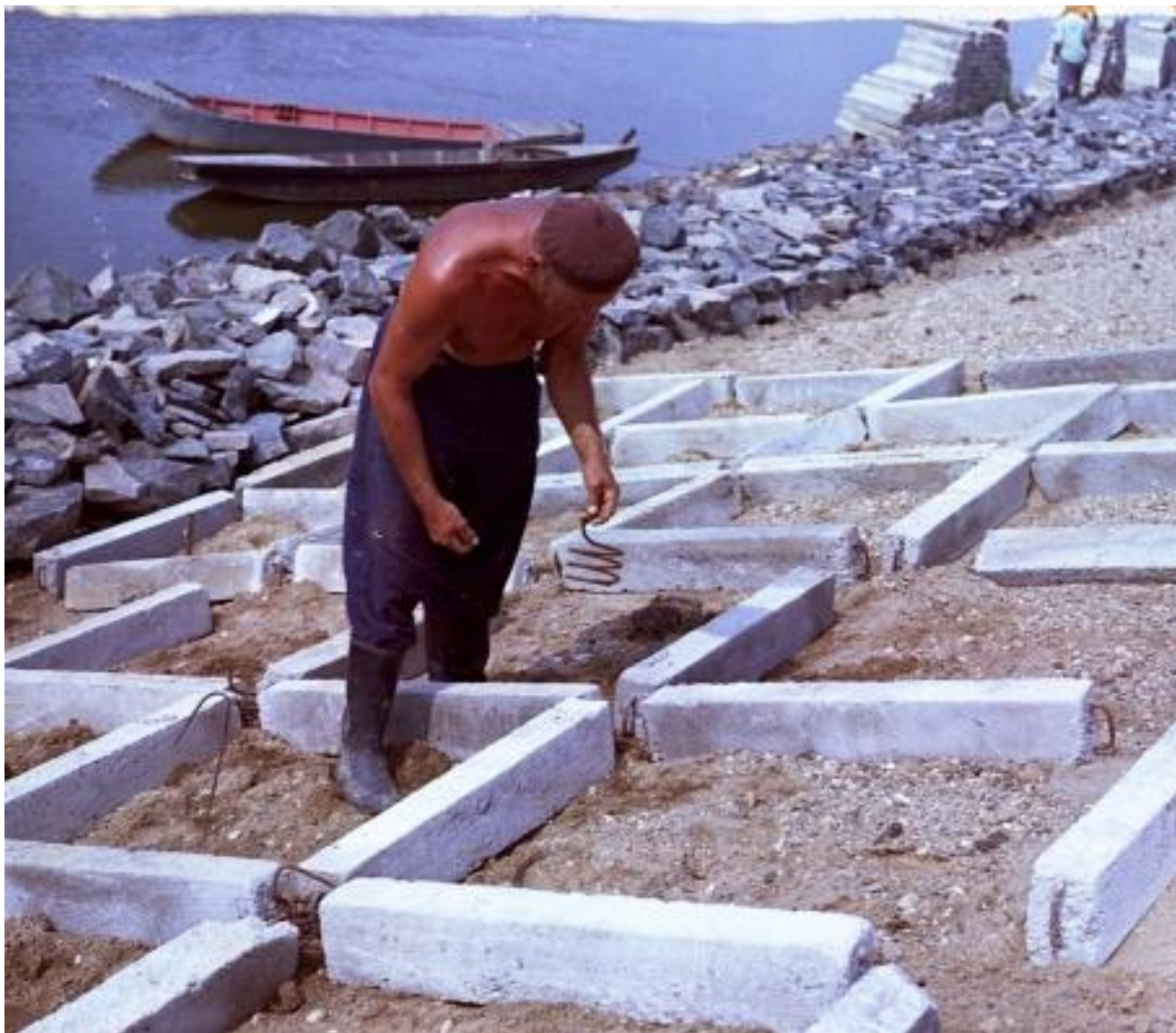
„KMZ” típusú, vasbetongerenda-rácsos partburkolat építése
