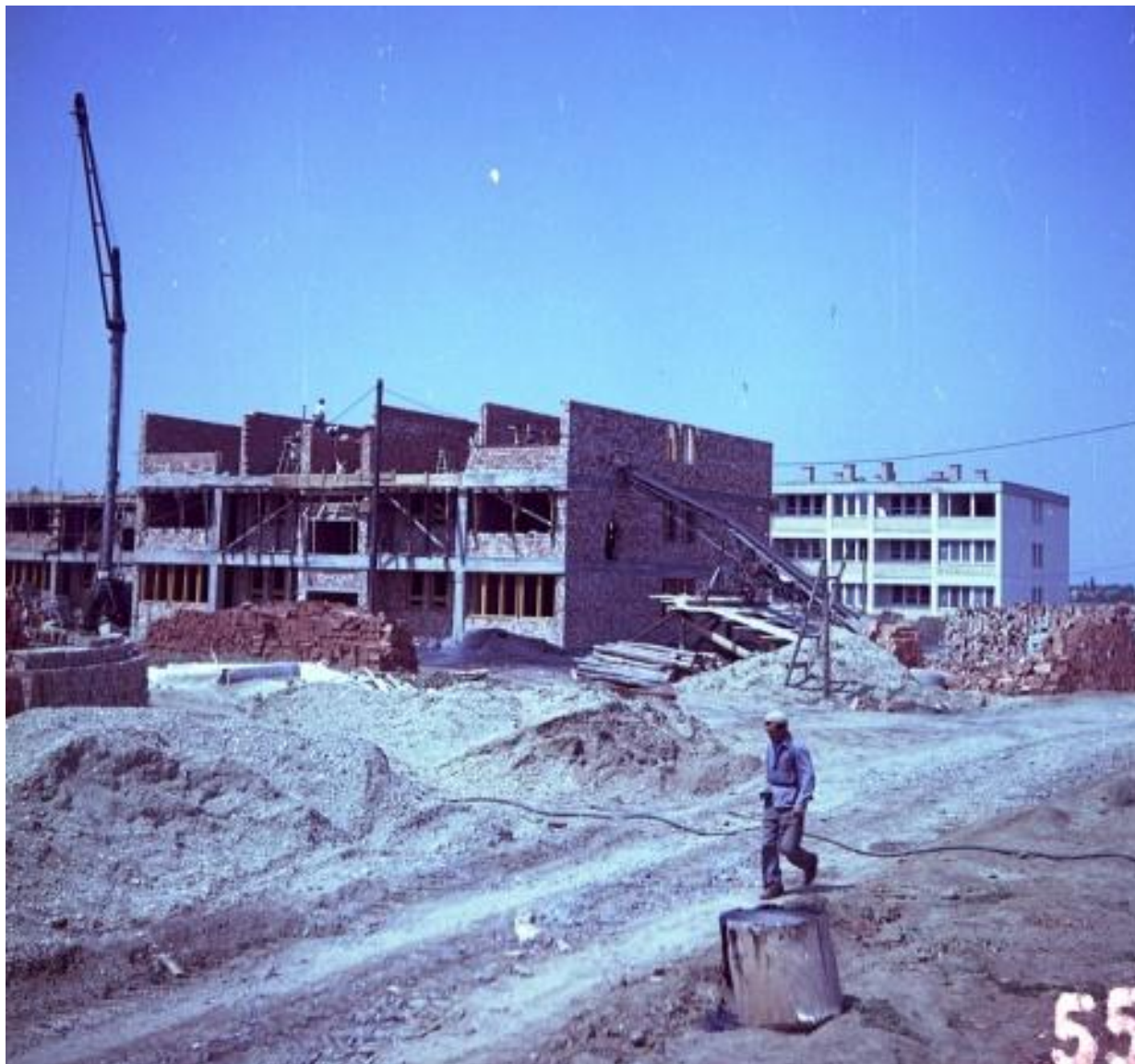
Lakótelepi épületek építése
