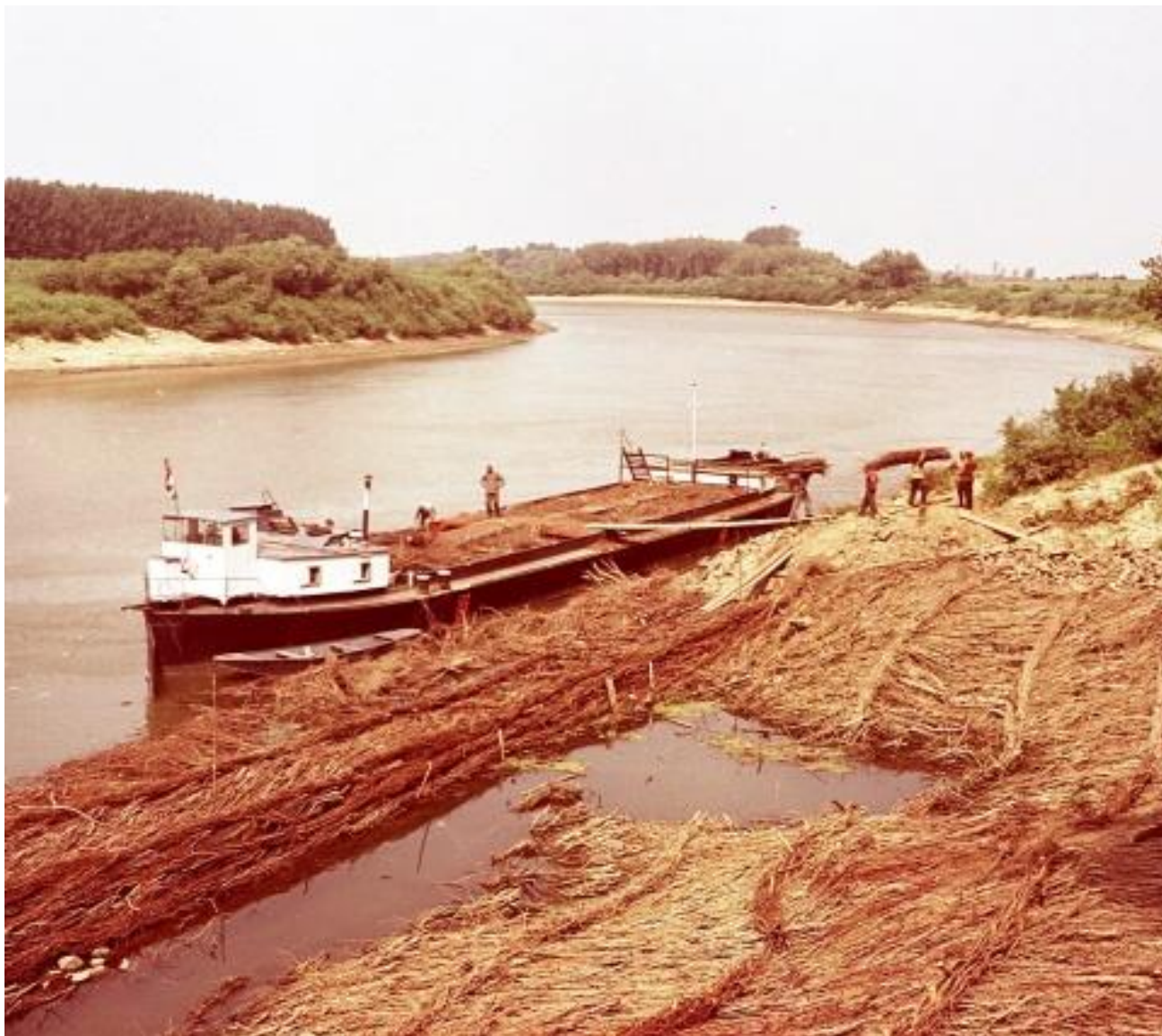
Rözsepaplan készítése, elhelyezése
