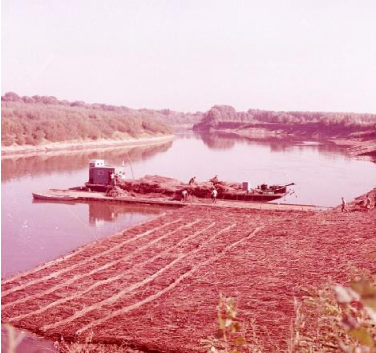
Rözsepaplan készítése, elhelyezése
