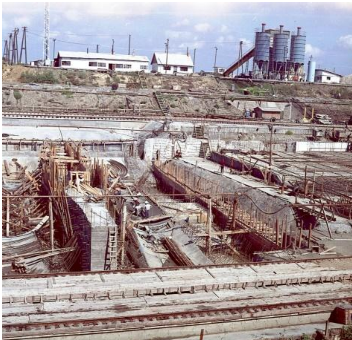
Turbinaházak szerelése és betonozása
