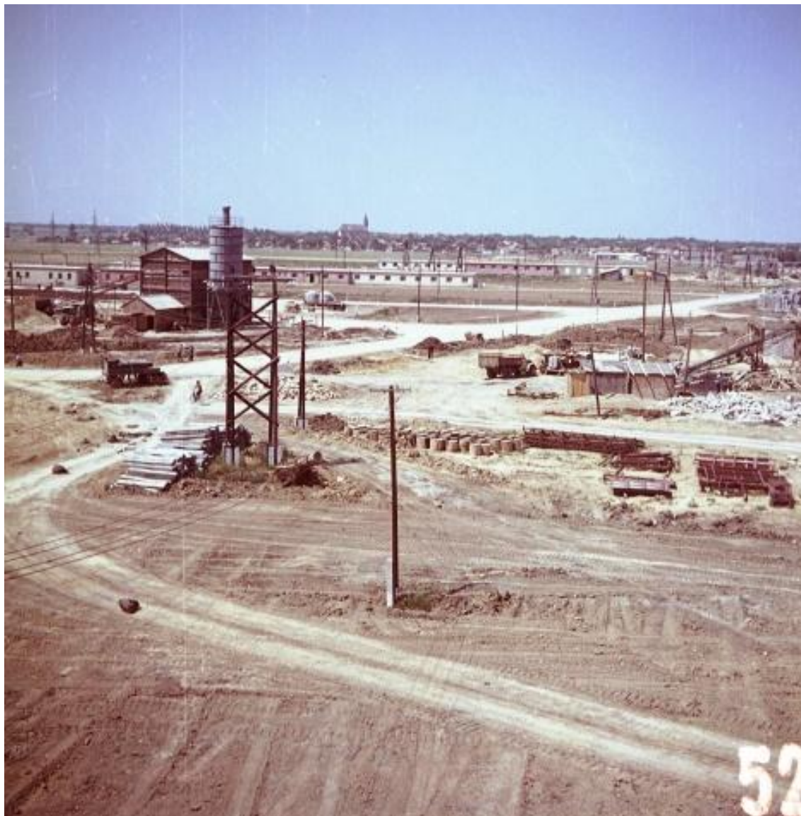
Felvonulási és lakótelepi területek rendezése, épületek kialakítása
