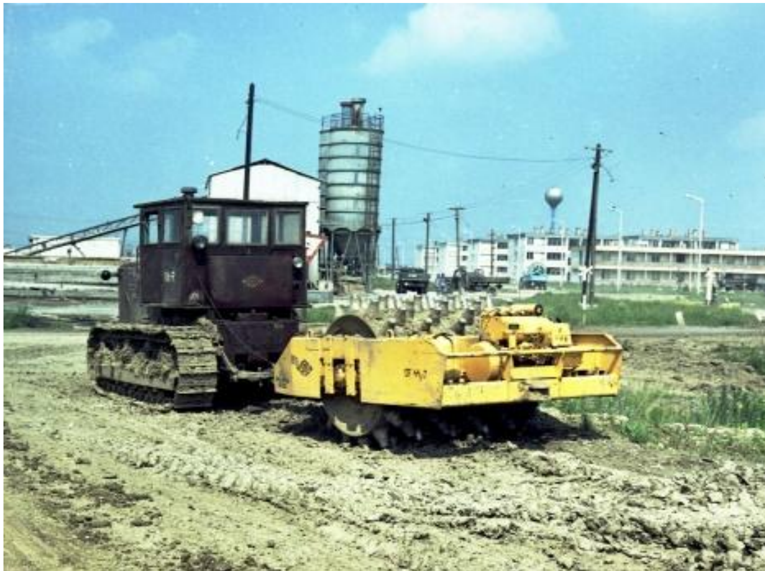
Tömörítés svéd vibro juhlábhengerekkel
