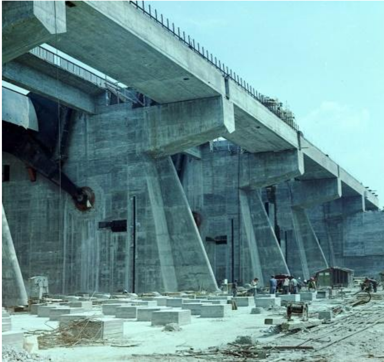
A duzzasztómű építése, energiatörő fogak
