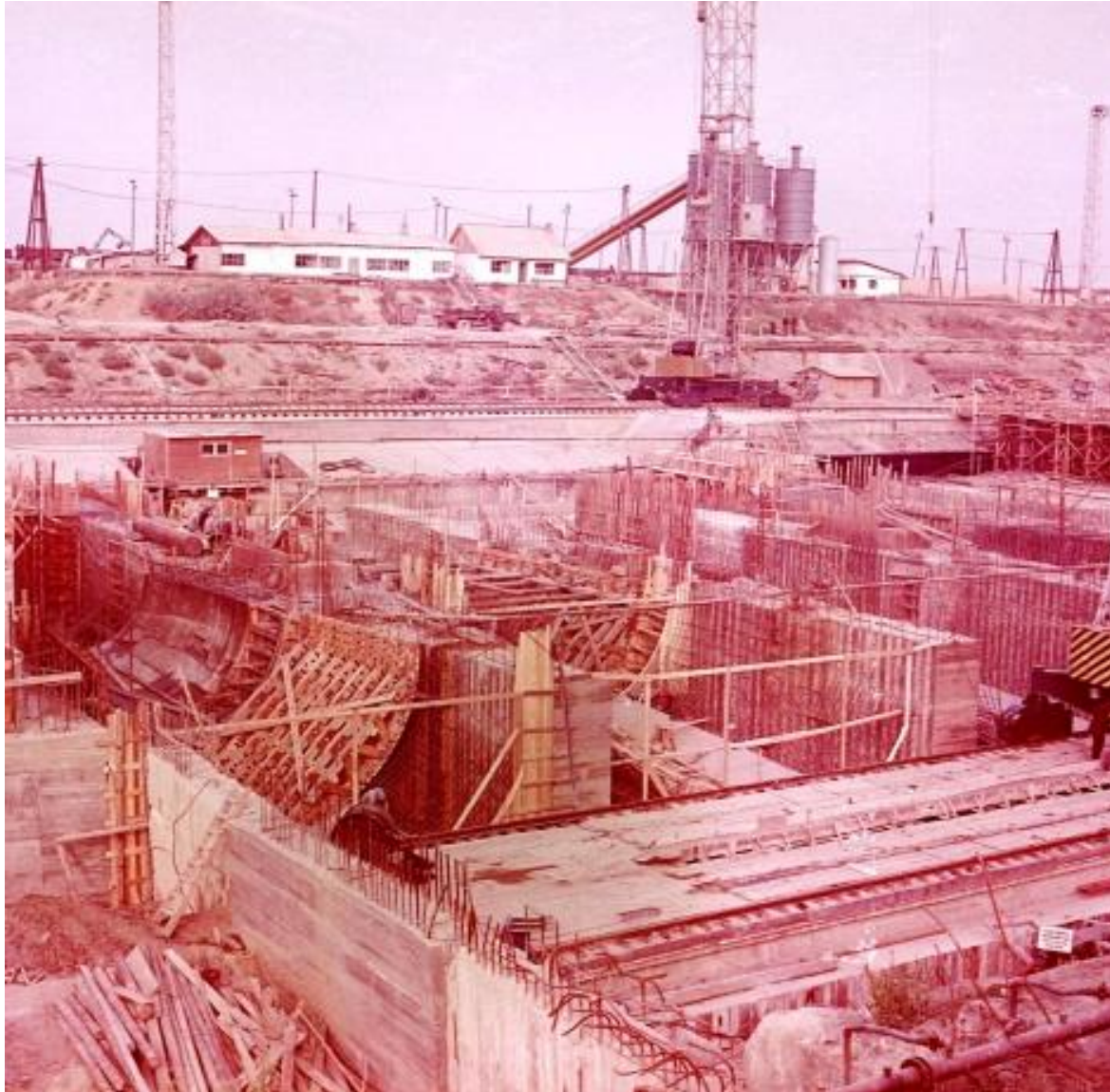
Turbinaházak szerelése és betonozása
