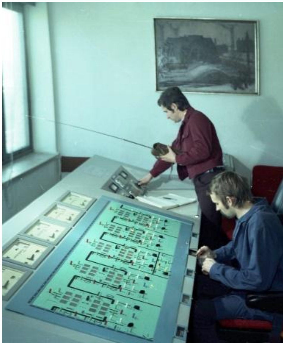
A duzzasztómű öt mezős vezérlőasztala
