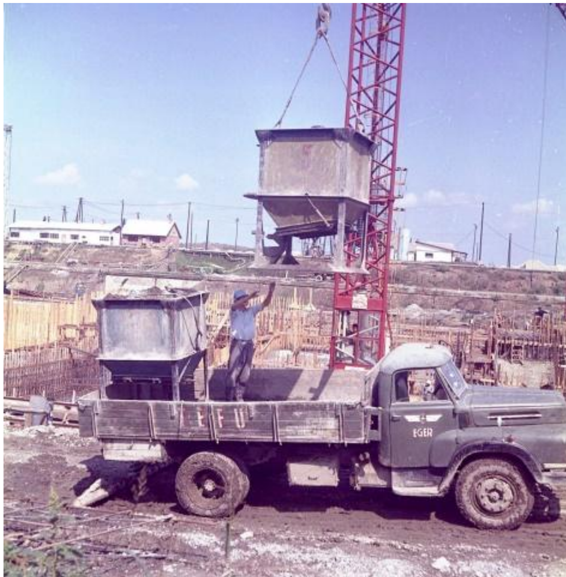
A betont 1 m 3 -es konténerekben szállították, daruk, toronydaruk emelték a bedolgozás helyére
