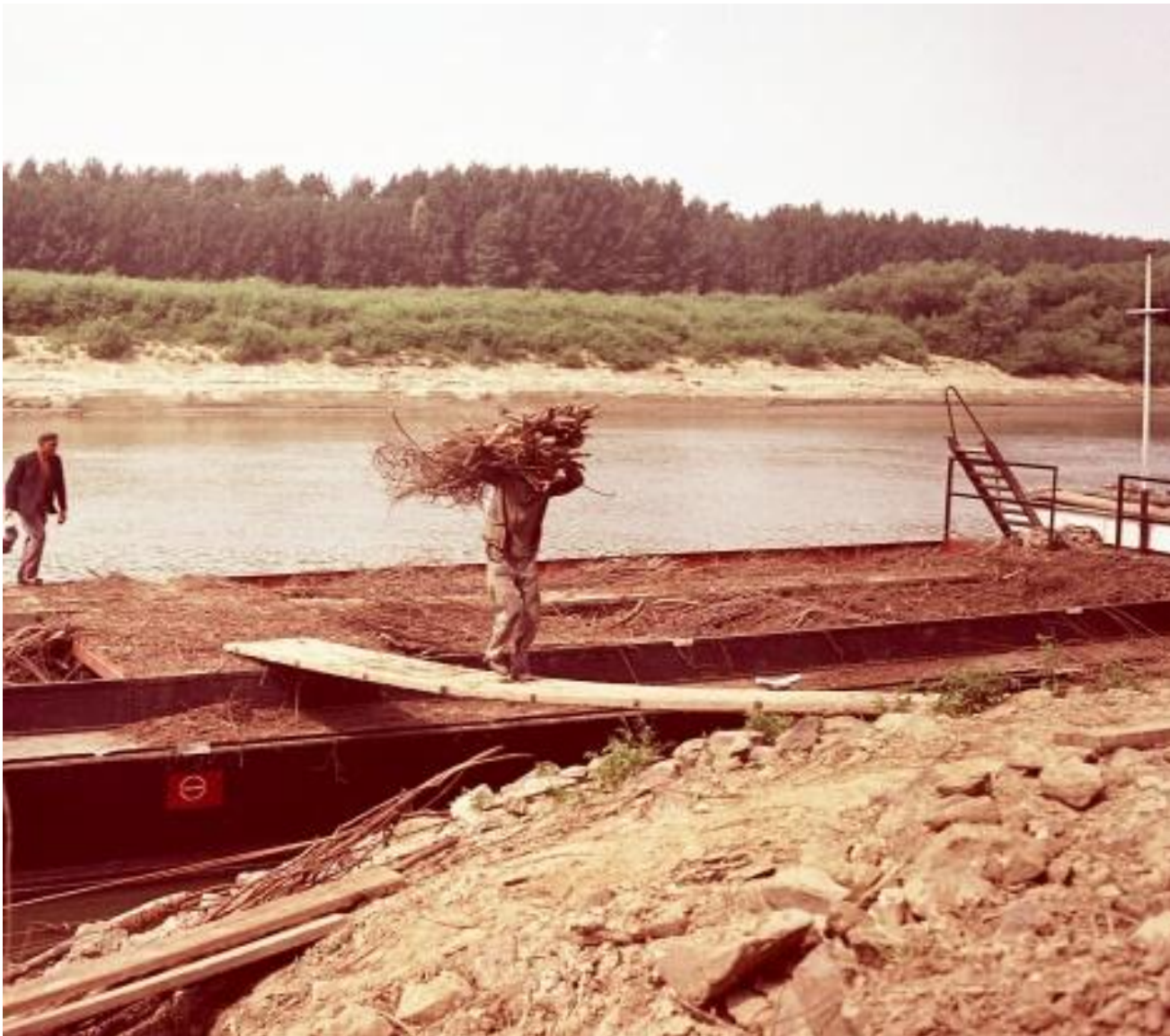
Rőzsepaplan készítése, elhelyezése
