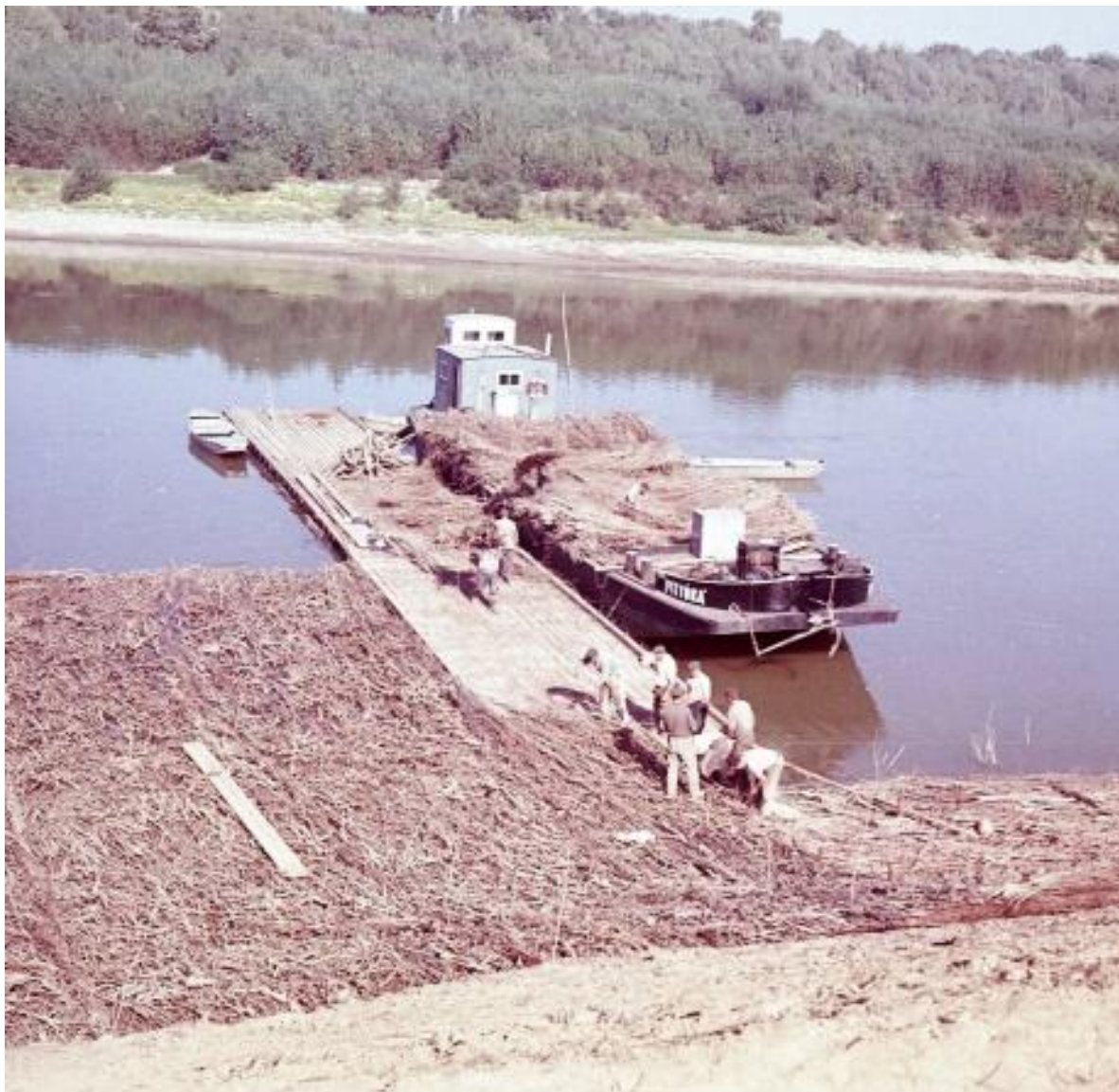
Rózsepaplan készítése, elhelyezése
