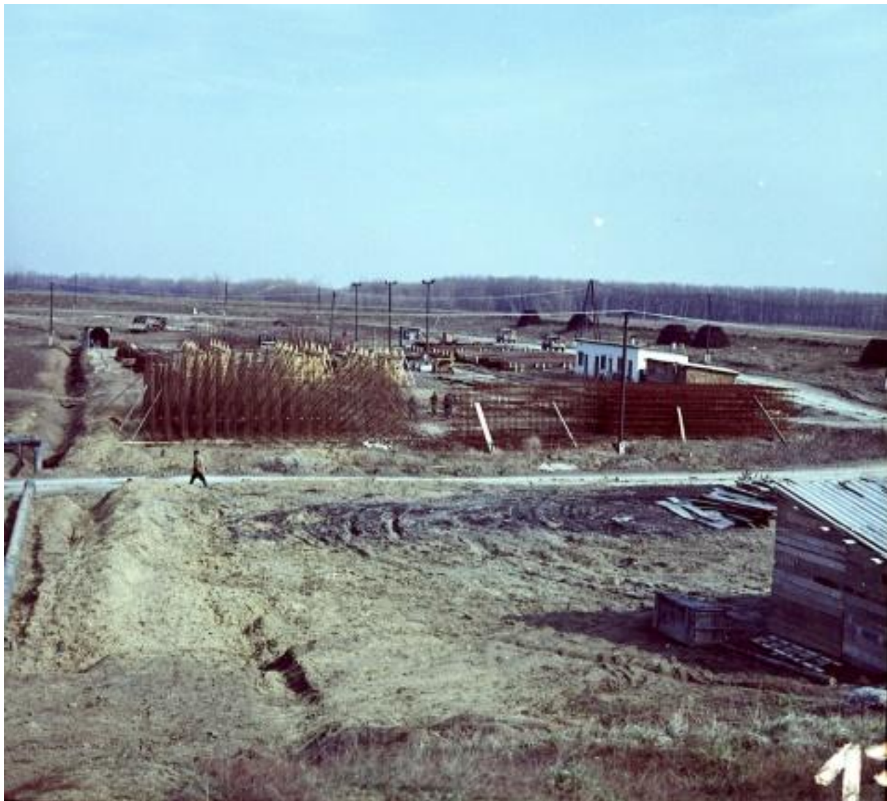
Ácstelep és betonvasszerelő telep
