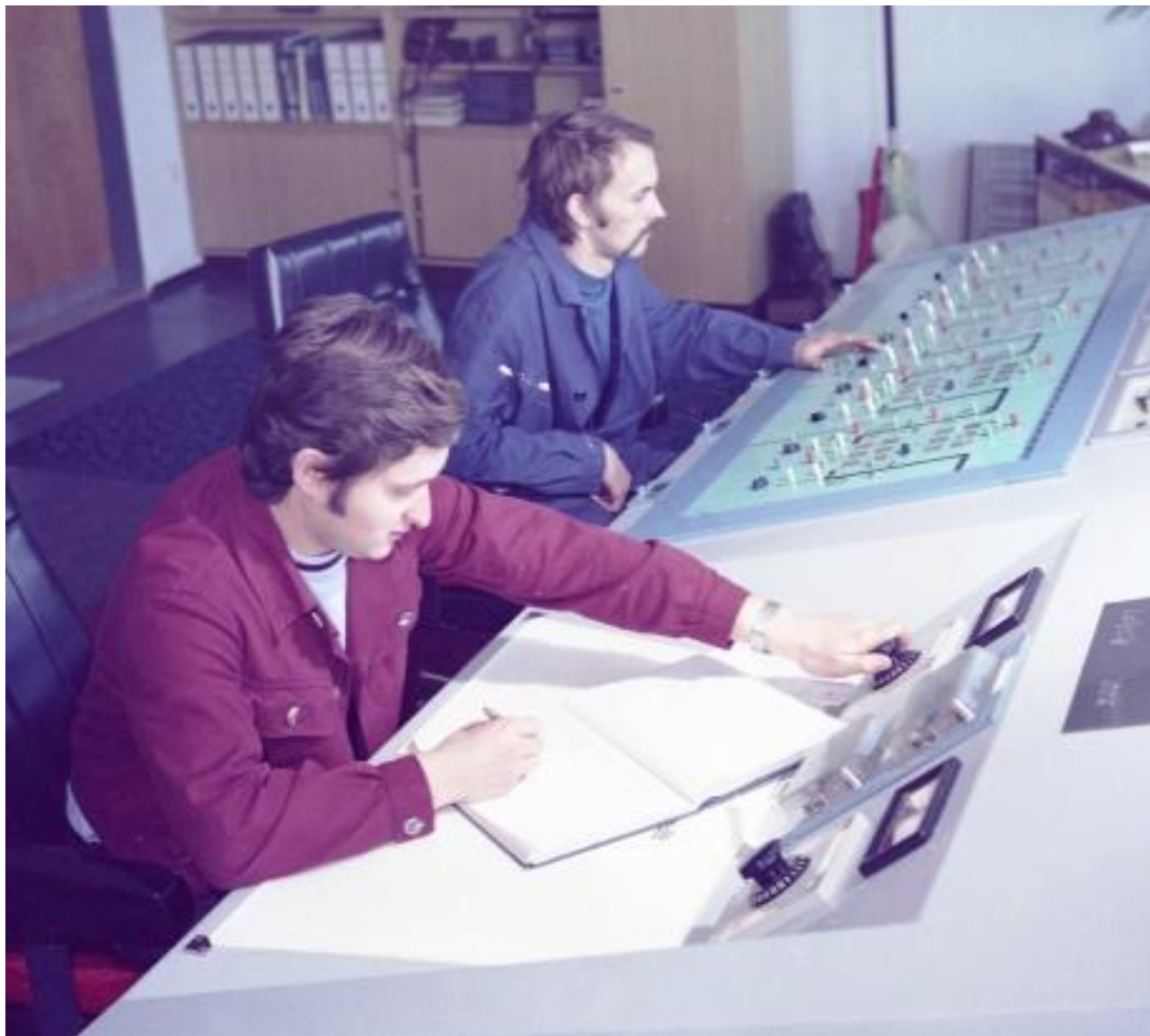
A duzzasztómű öt mezős vezérlőasztala
