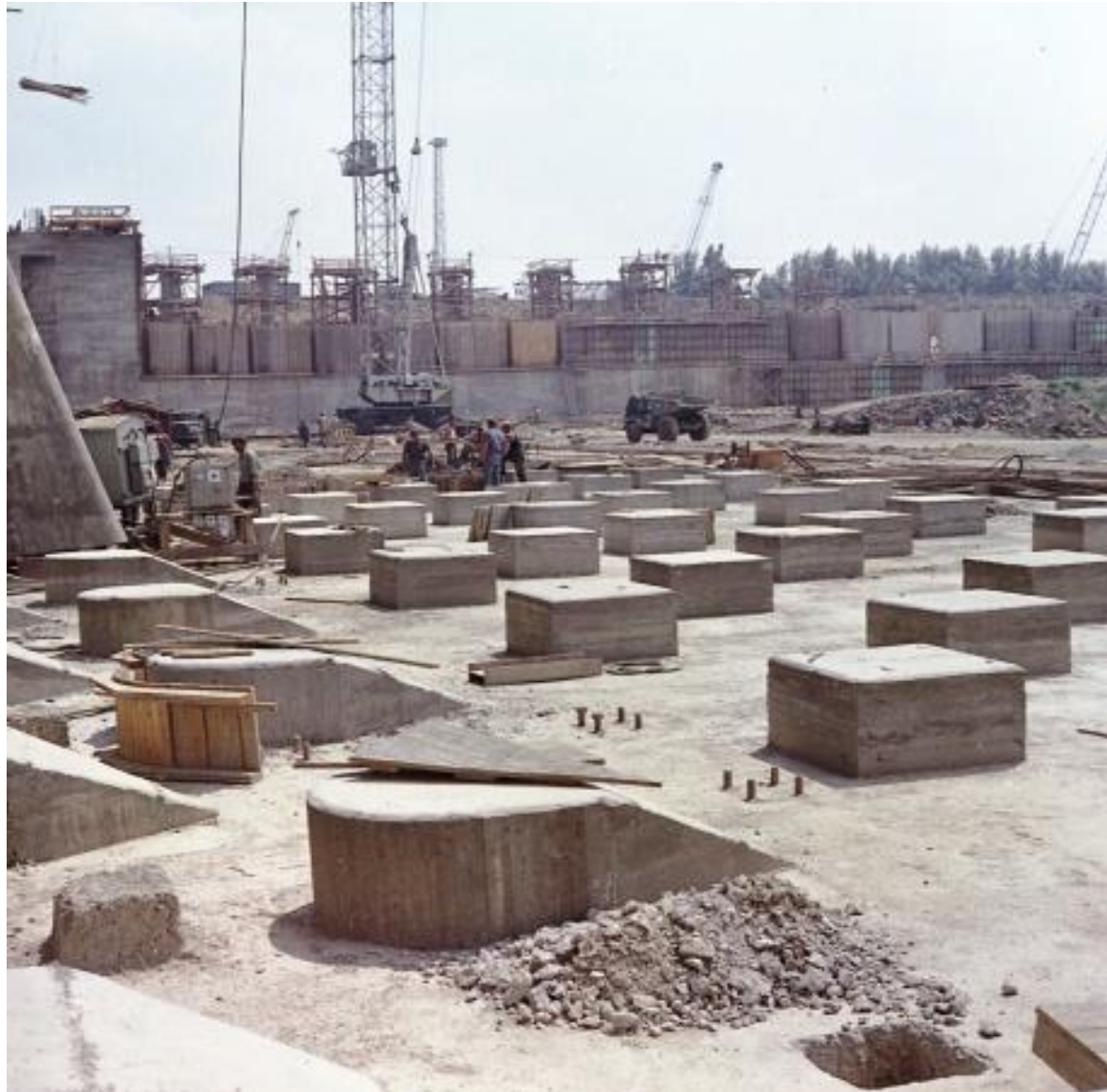
A hajózsilip és az energiatörő fogak építése
