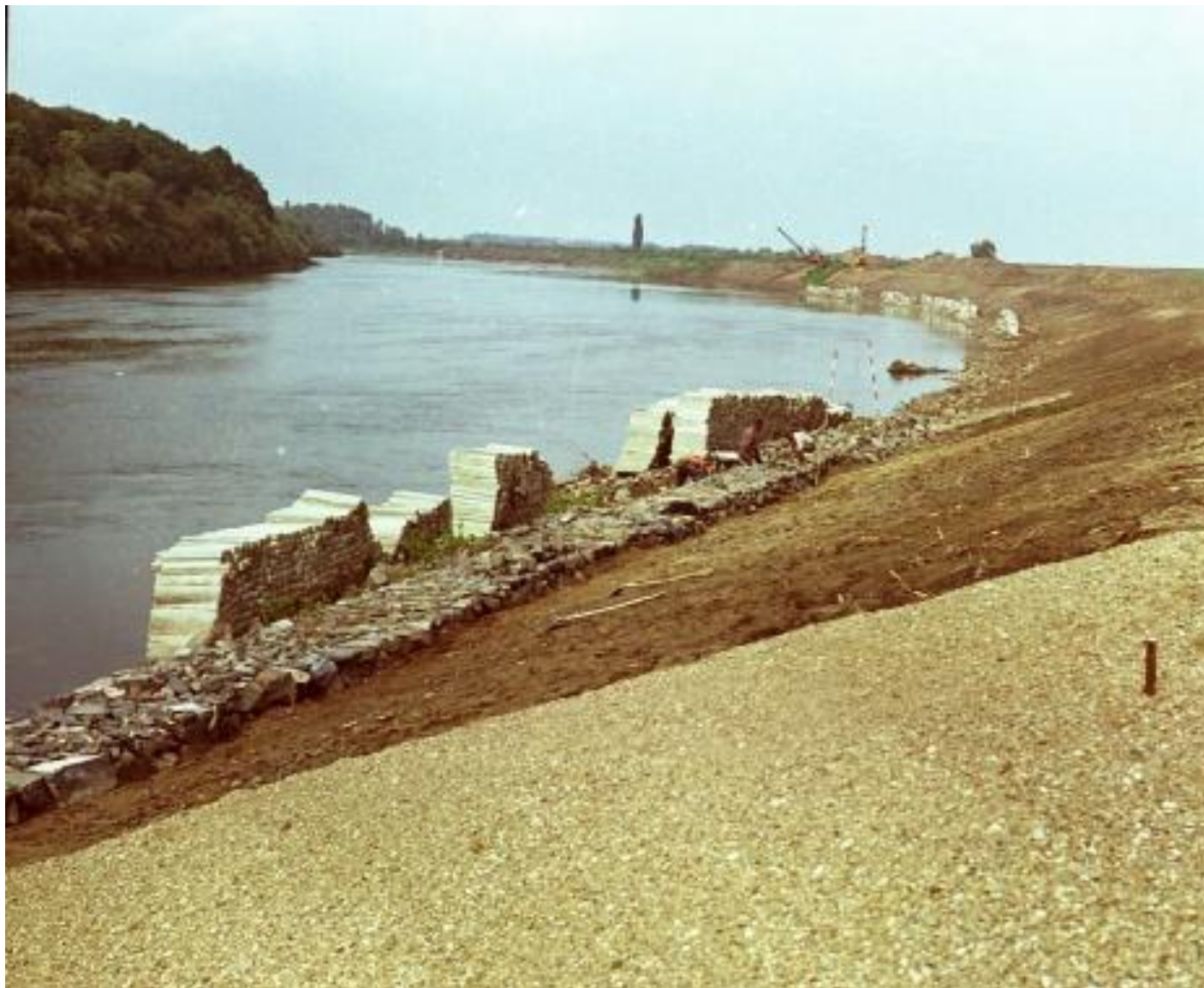
Az új meder végleges részüinek és partvédelmének kialakítása
