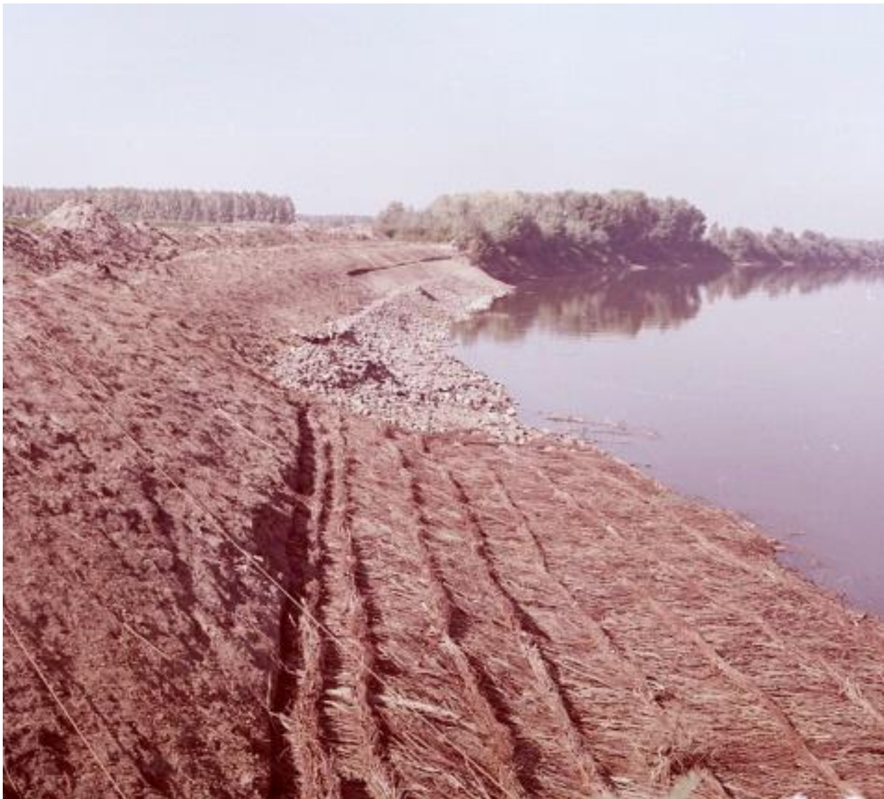
Rözsepaplan készítése, elhelyezése
