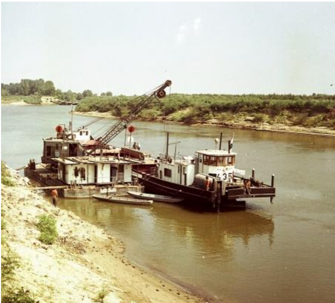
Úszótágra helyezett hidraulikus polip-markoló a vízi úton érkező anyagok kirakodásához
