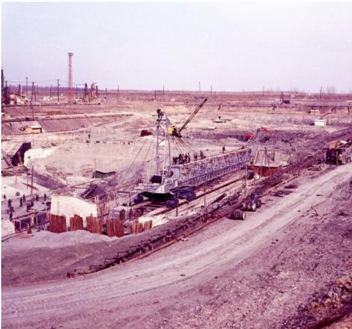
Toronydaru összeszerelés
