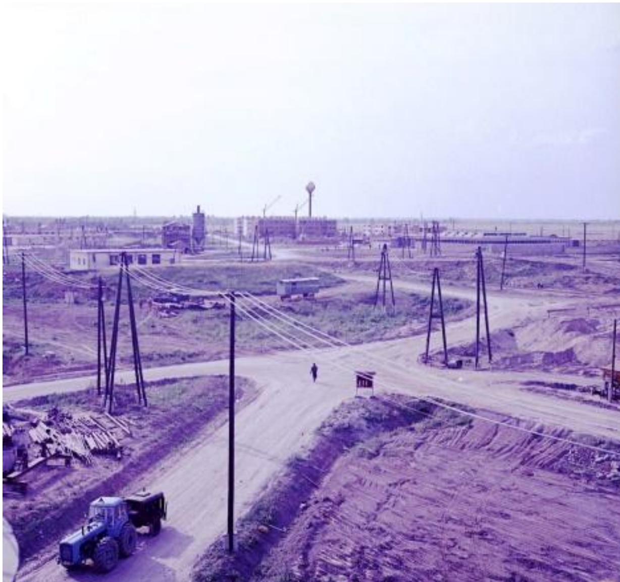
Felvonulási és lakótelepi épületek kialakítása
