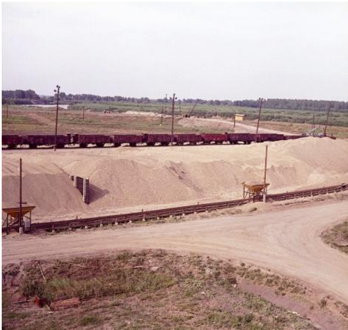
Osztályozott kavics tároló (max. 30.000 m 3 ), háttérben a IV. iparvágány
