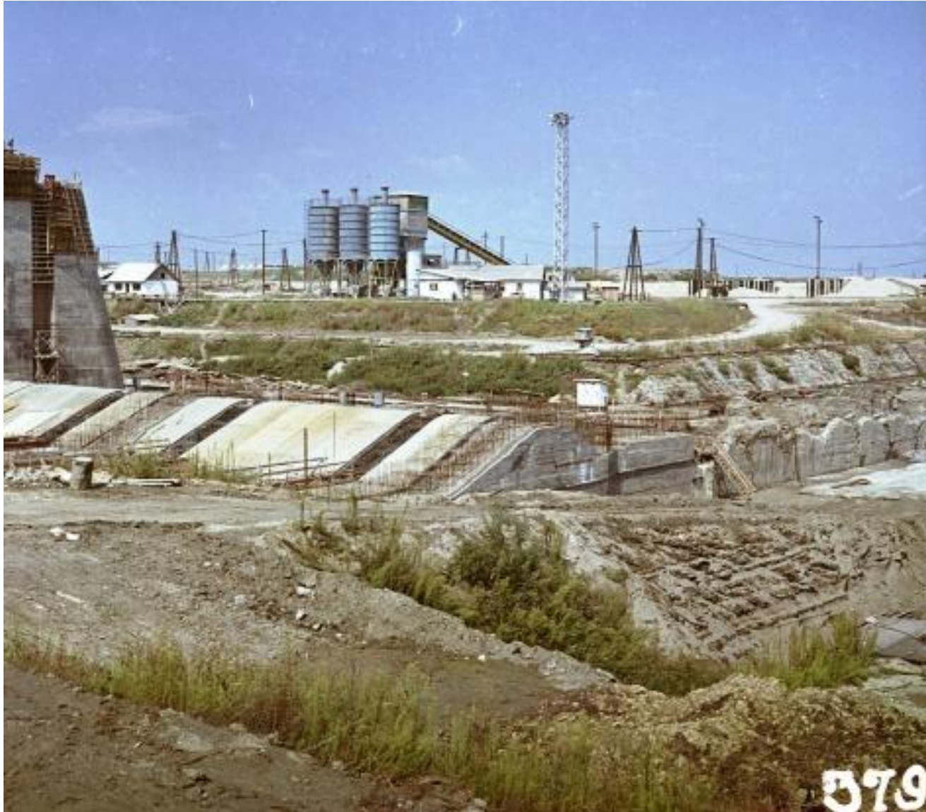
A duzzasztómű építése
