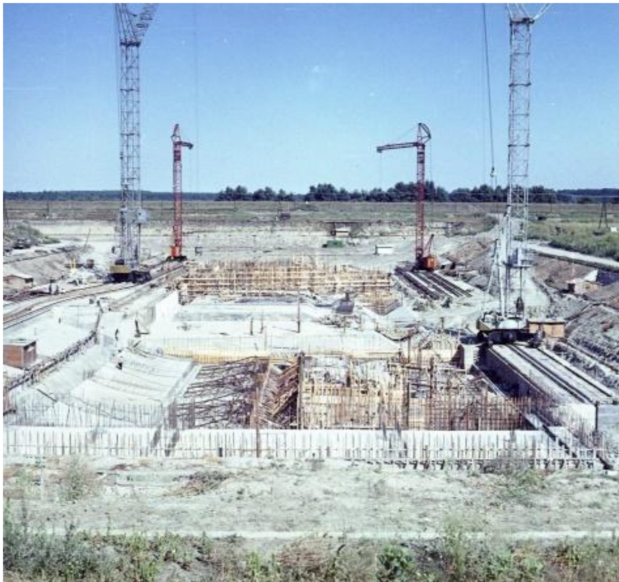
Toronydaruk elhelyezkedése a munkagödörben
